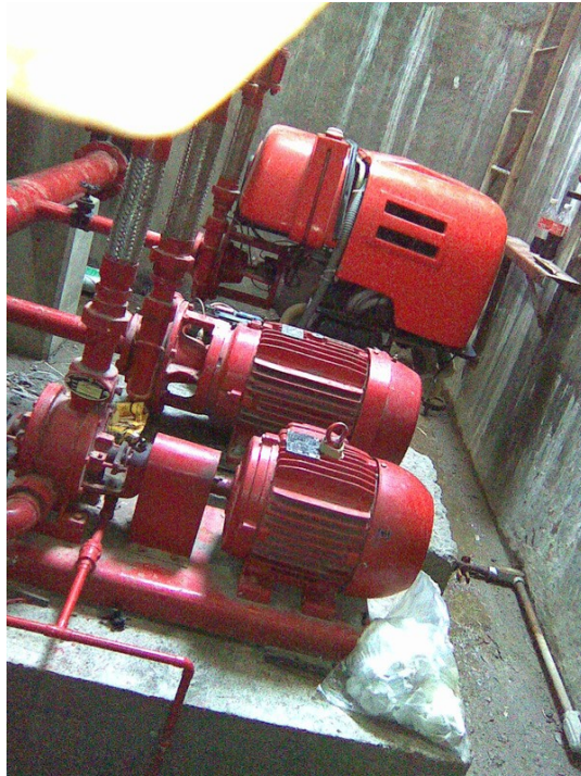
Bombas del sistema contra incendio en espera de reparación.
