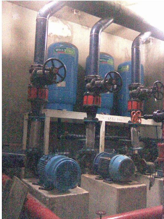
Los tres tanques de aire a presión (globos), uno requiere mantenimiento.
